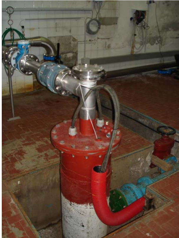
Figura 143. Pozzo di via Acquedotto. Si nota il cavo bianco fissato alla testa del pozzo con cui è stato calata la sonda.
